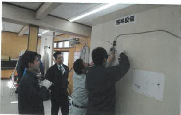
照明工事 実習
